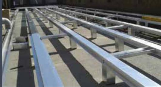
Vom Starterprofil ausgehend, fortlaufend aufstellen. Abstände der Trägerprofile und das Ausrichten der Höhenlagen mit dem Richtscheit laut Verlegeplan. Querträger mit Standardabstand befestigen und Trägerprofile wie Starterprofil im Achsraster gem. Verlegeplan auslegen.
