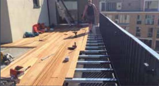
Nach dem Überprüfen der Dachabdichtung und der Anschlüsse wird die Verlegerichtung festgelegt und die Höhendistanz mit dem Gefälle abgestimmt. Nach dem Auslegen der Distanzklötze wird das Starterprofil aufgesetzt und ausgerichtet und die Schiene mit den Distanzklötzen verschraubt.
