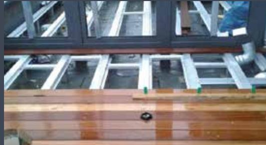
Rinnen und sonstige Sonderkonstruktionen anlegen bzw. montieren. Auflegen des Belages (Holz, Betonplatten oder andere).
